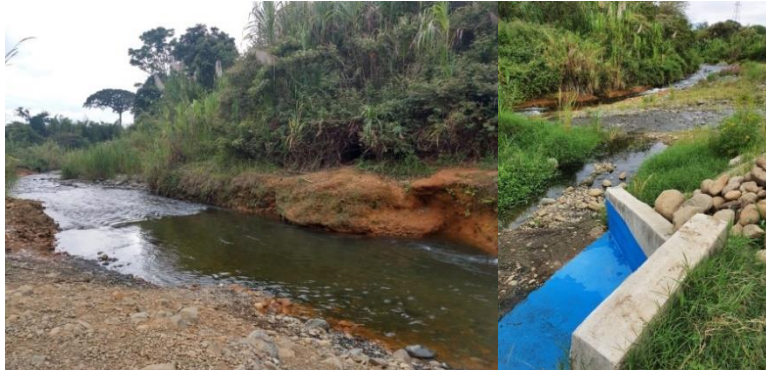
Figura 157. Descargue de la Planta de Tratamiento de Aguas Residuales (PTAR) directamente al río en zona de La Viga
