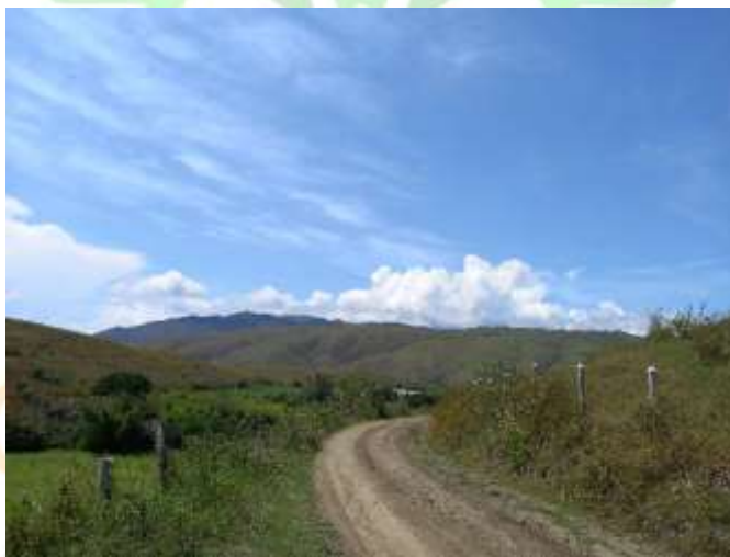
Figura 11. Vías terciarias, sin pavimentación.
